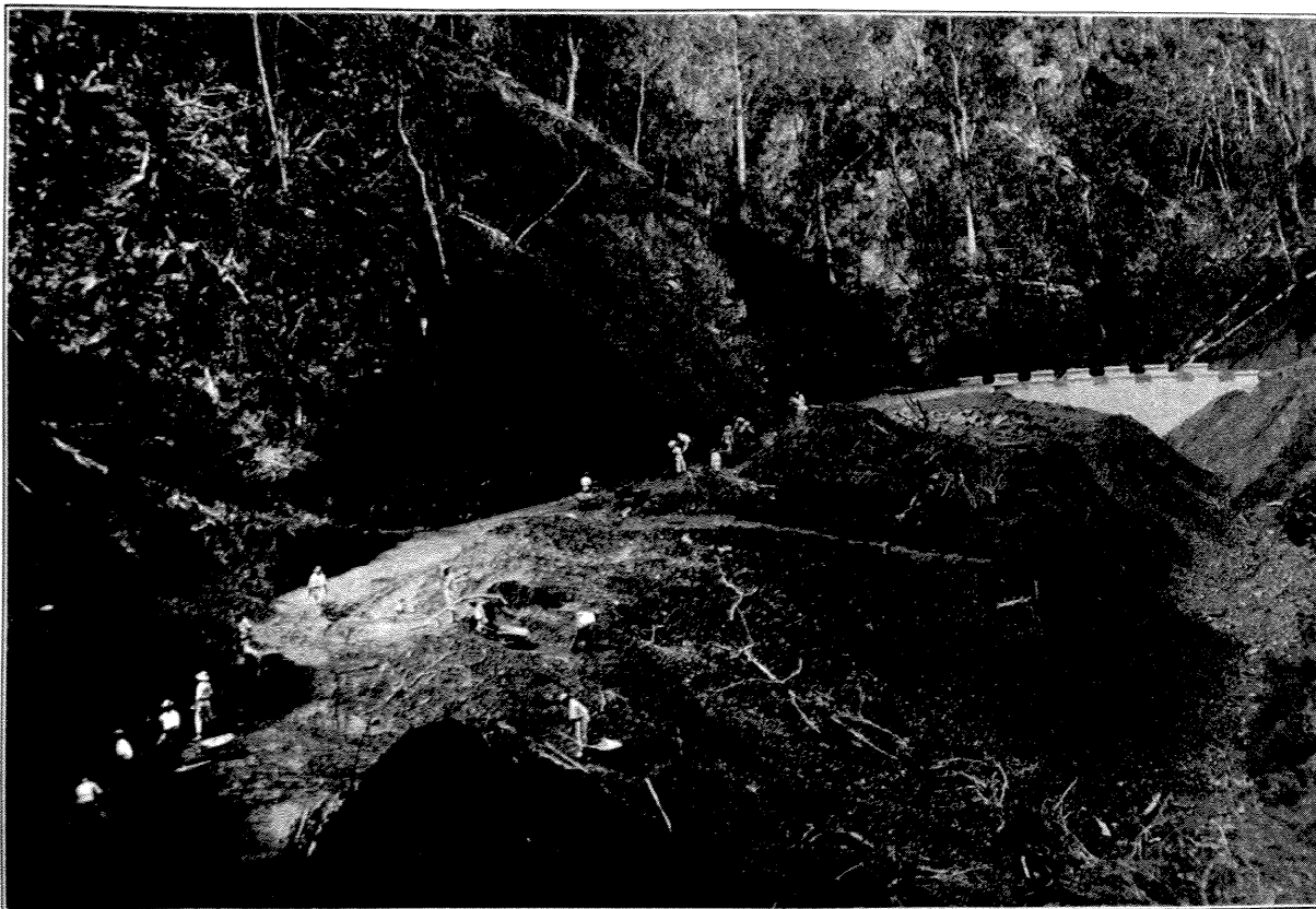
CARRETERA EN CONSTRUCCIÓN.—A BUSY DAY ON PORTO RICO'S HIGHWAY CONSTRUCTION.
