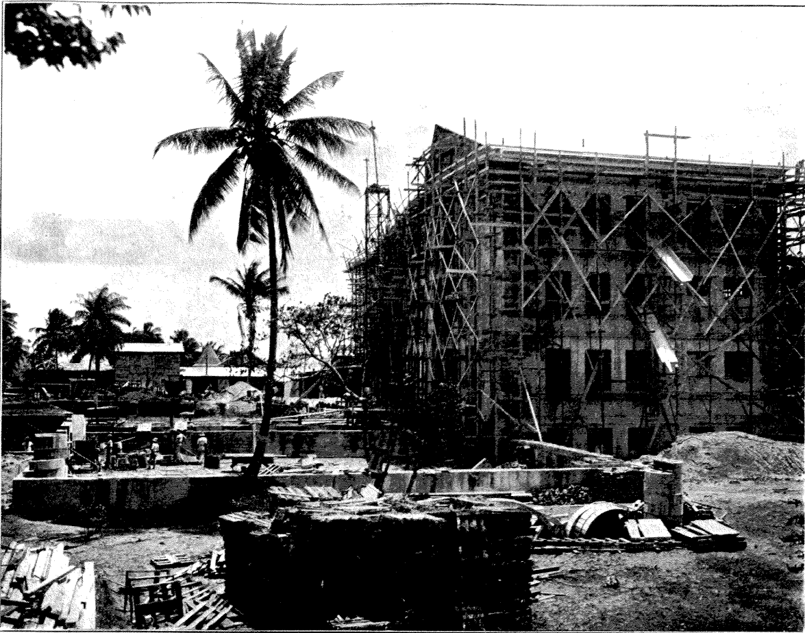
ALTA ESCUELA DE SAN JUAN, EN CONSTRUCCIÓN.—HIGH SCHOOL IN COURSE OF CONSTRUCTION.
