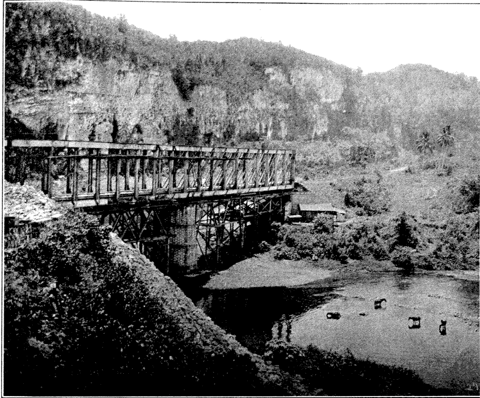
PUENTE DEL FERROCARRIL SOBRE EL RÍO CIALES.—SCENE ON THE PORTO RICO-AMERICAN R.R.
